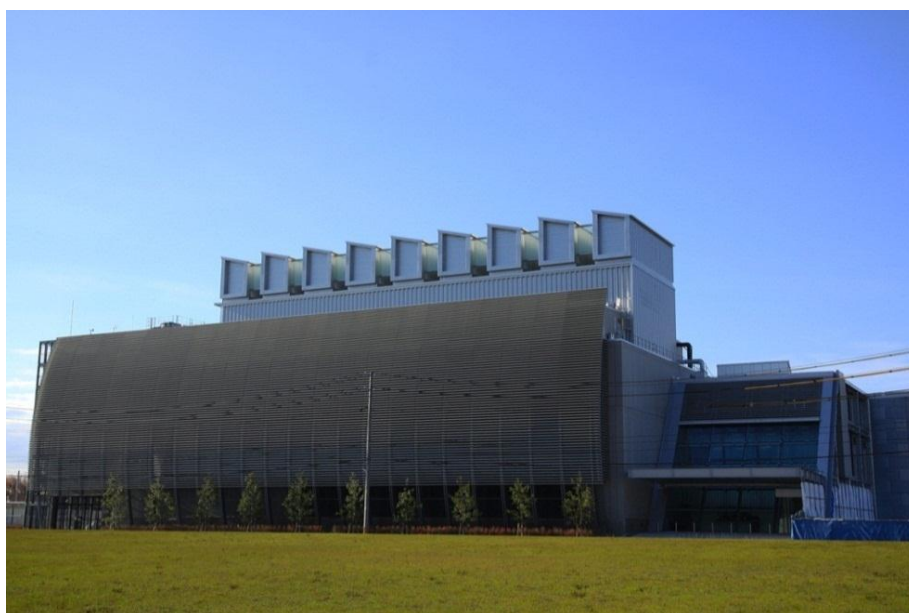
IDC フロンティア 白河データセンター
